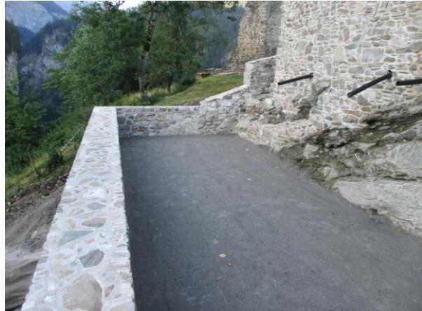
Bild rechts: Die Verschleisschicht ist eingewalzt
