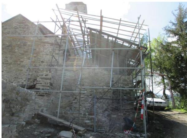
Bild rechst: Schutzdach über Bau 1 muss höher werde
