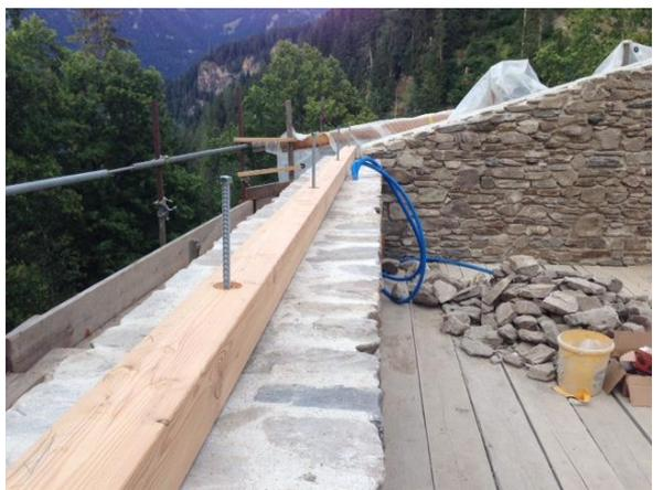
Bild rechts: Die Gewindestangen werden eingegeben
