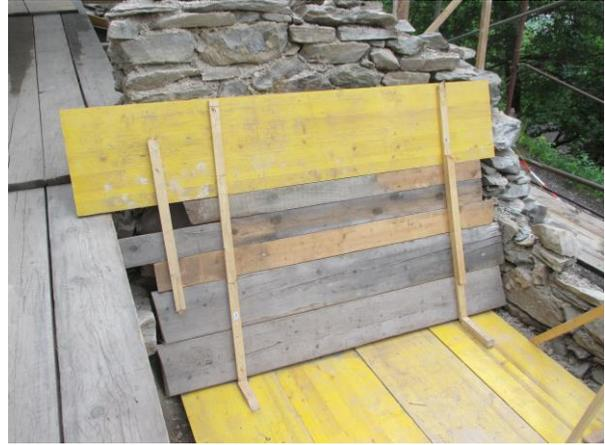
Bild rechts: Der originale Wandmörtel wird geschützt
