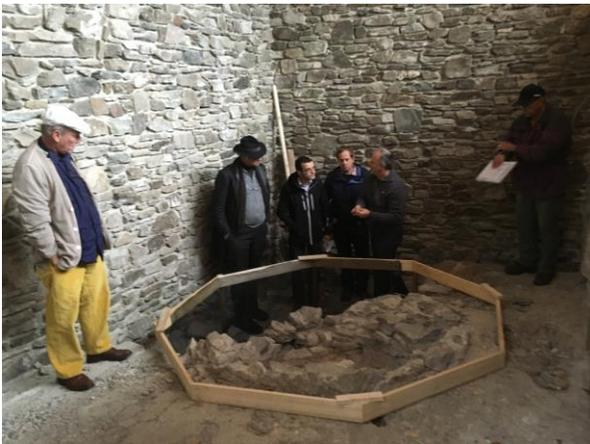
Bild links: Begehung am 29. Oktober (v.l.n.r) R. Krebs, J. Conzett, S. Berger, Th. Reitmaier, M. Mutter, R. Küntzel. Oktogonalring aus Holz markiert den zukünftigen Stahlrahmen und die Höhe der Schutzmörtelschicht
